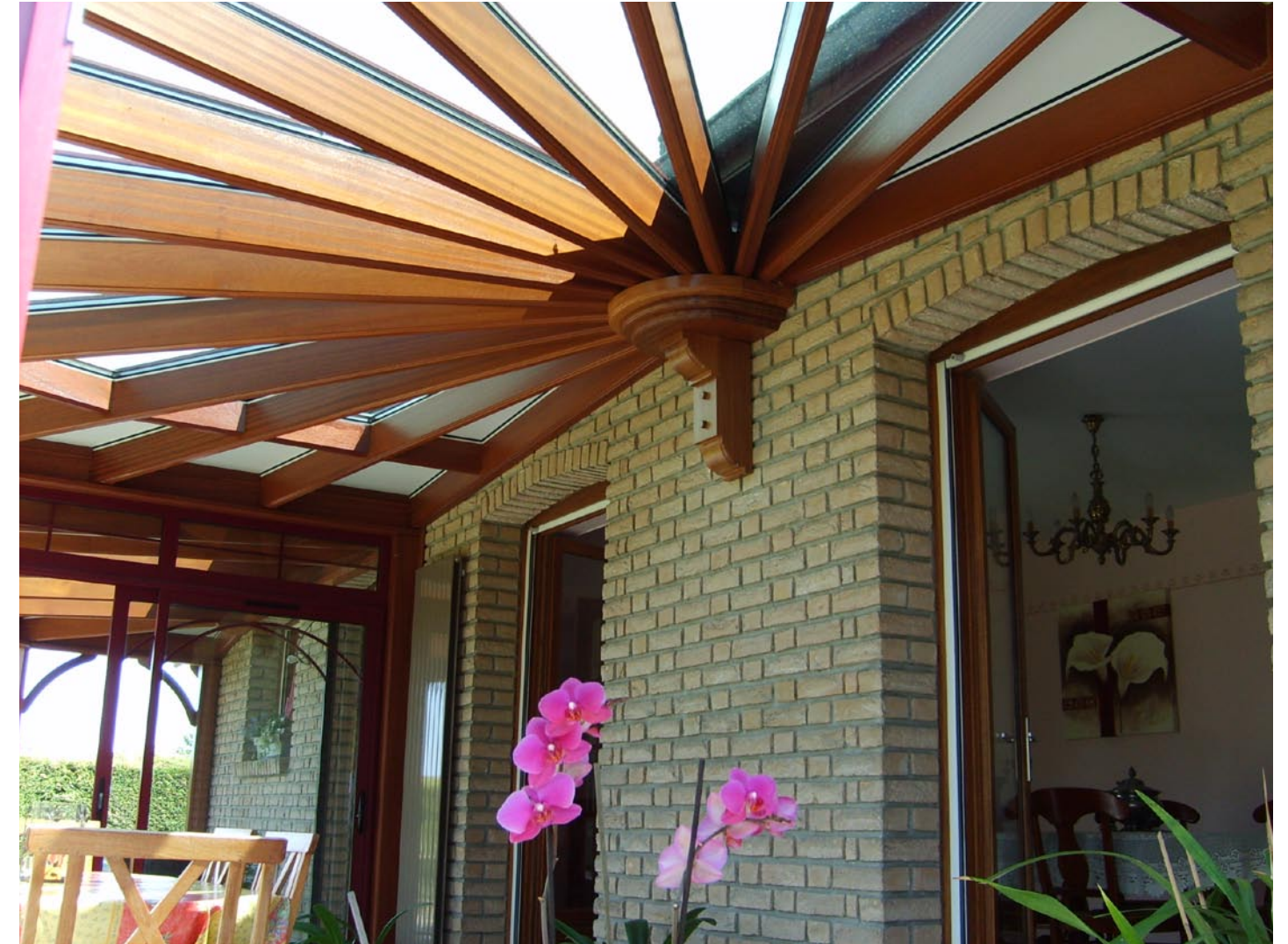
Ci-dessus : Une charpente rayonnante soutient le vitrage et les panneaux opaques.
